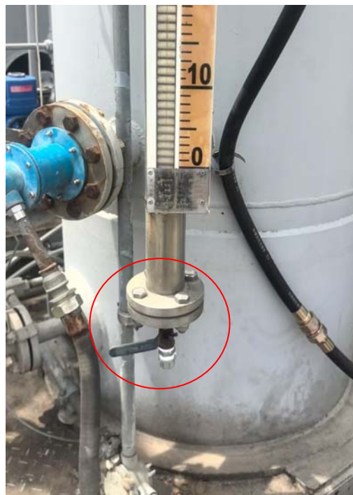
整改后排放阀已设置丝堵
